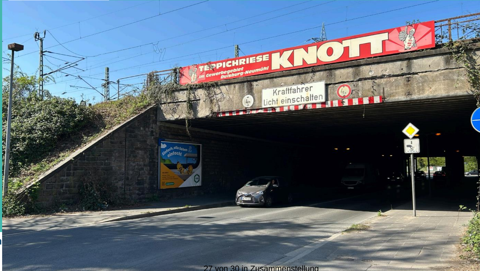
Unterführung Ruhrorter Straße
