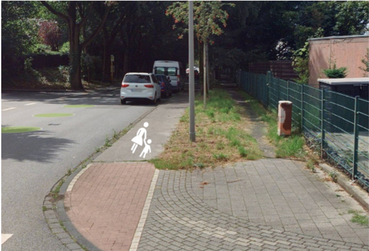
Abbildung 1: Umnutzung des baulichen vorhandenen Hochbordradwegs als Gehweg
