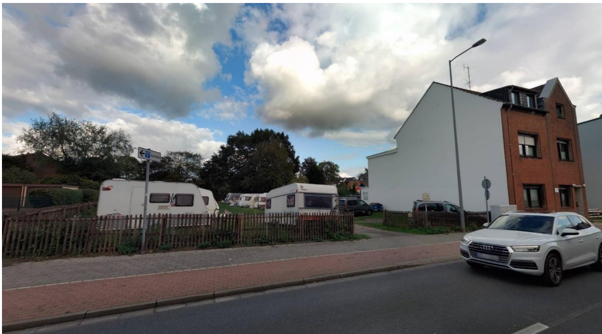
Abbildung 2: Aufhebungsgebiet, Straßenansicht mit Blickrichtung Nord © cyclomedia
