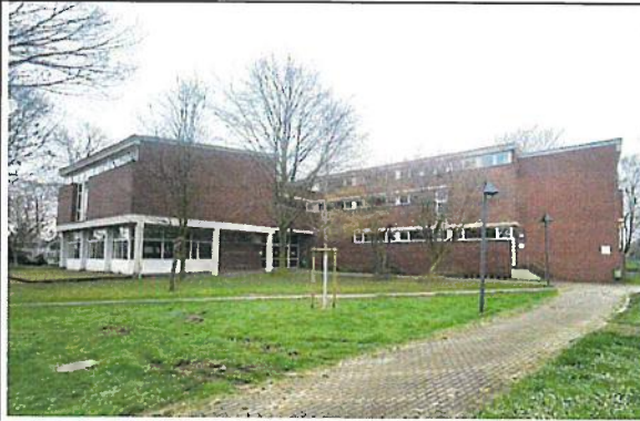
Ehem. Oberhausen-Institut, Blick auf das Naturwissenschaftliche Schulgebäude, Ansicht von Nord. Foto: Stadt Oberhausen.
