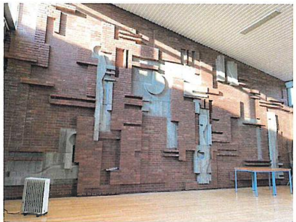
Ehem. Oberhausen-Institut, Aula im Naturwissenschaftlichen Schulgebäude. Foto: Stadt Oberhausen.
