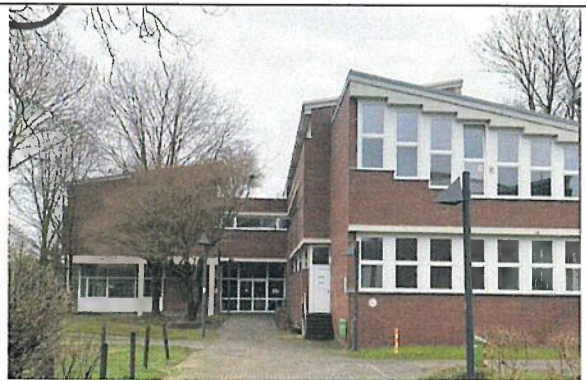
Ehem. Oberhausen-Institut, Blick auf das Naturwissenschaftliche Schulgebäude, Ansicht von Nord-West. Foto: Stadt Oberhausen.
