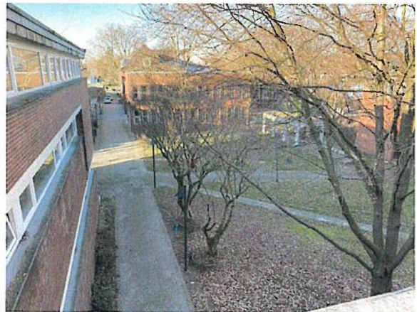
Ehem. Oberhausen-Institut, Blick auf die Freiflächen mit Pflanzkübeln und Gehwegen, Ansicht von Süd-Ost. Foto: Stadt Oberhausen.
