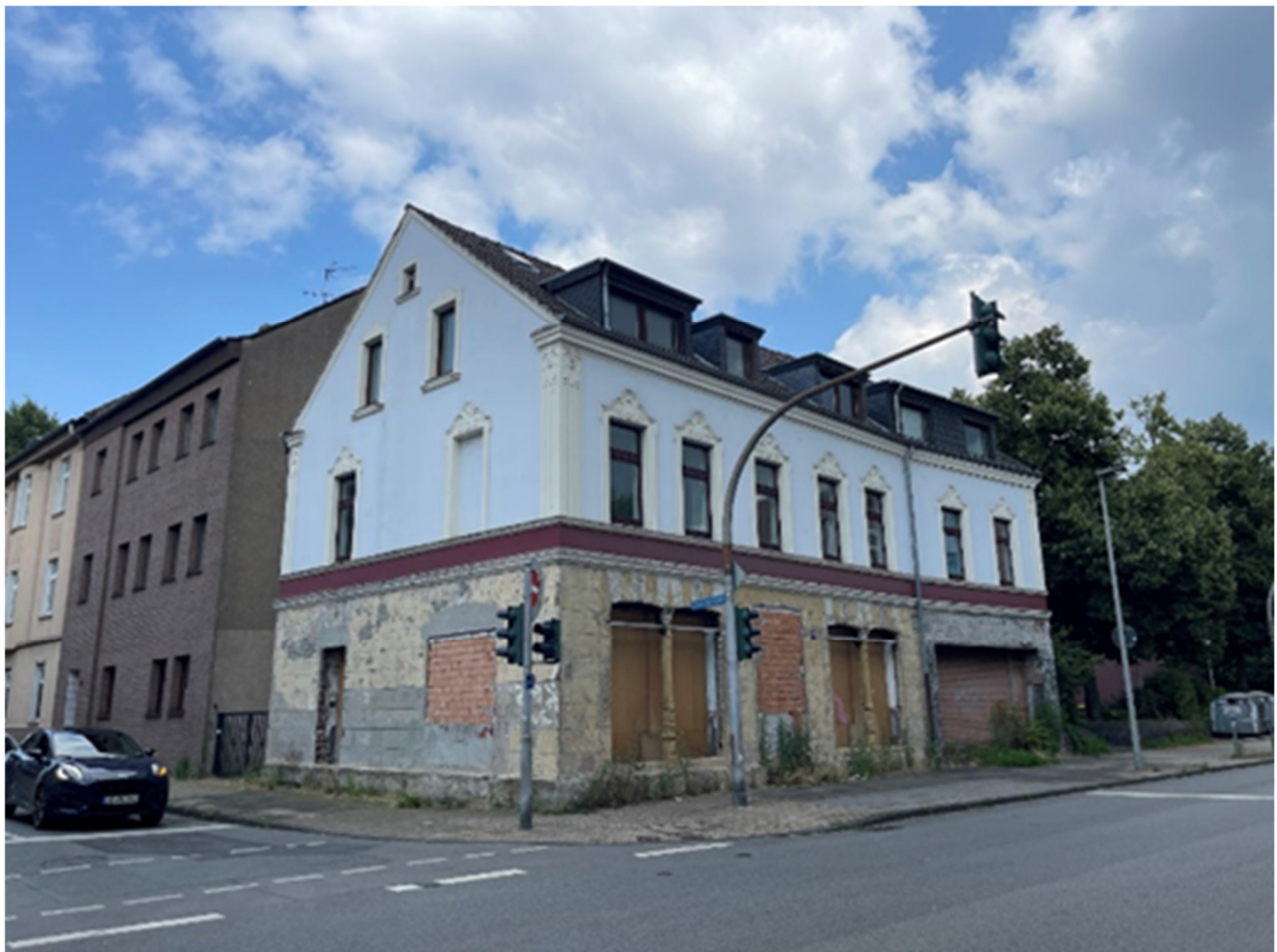
Abbildung 6: Beispiel für bauliche Mängel - Grenzstraße 88 - Foto Stadt Oberhausen
