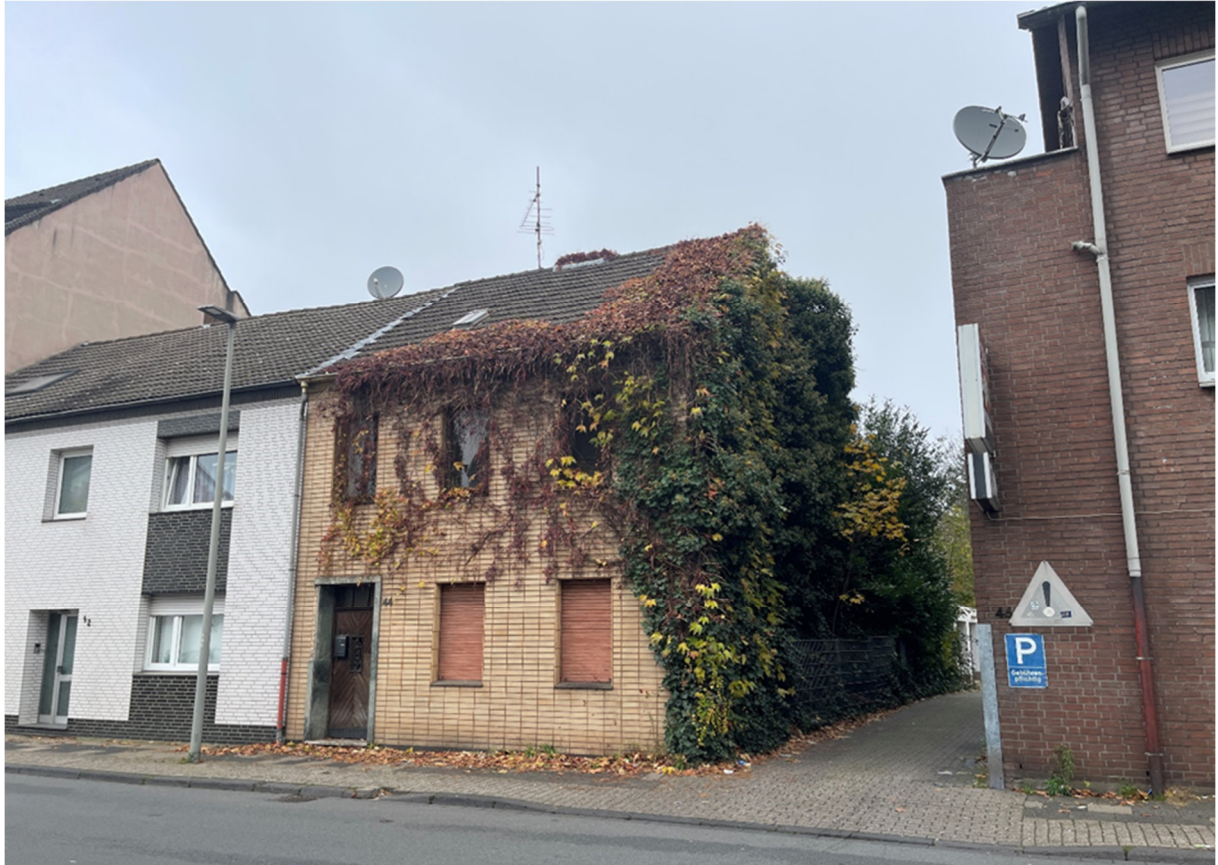
Abbildung 7: Beispiel für bauliche Mängel - Grenzstraße 44- Foto Stadt Oberhausen
