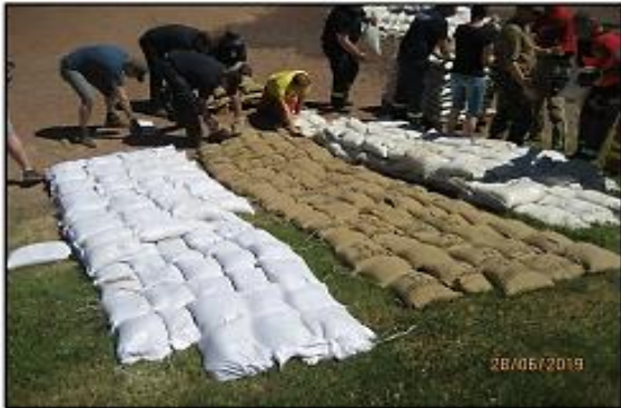
Auflast/Beschwerung (Foto: Akademie Hochwasserschutz)
