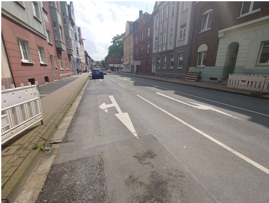
Abbildung 3: Fahrbahn Rheinische Straße – Westfälische Straße (Quelle: eigenes Foto)
