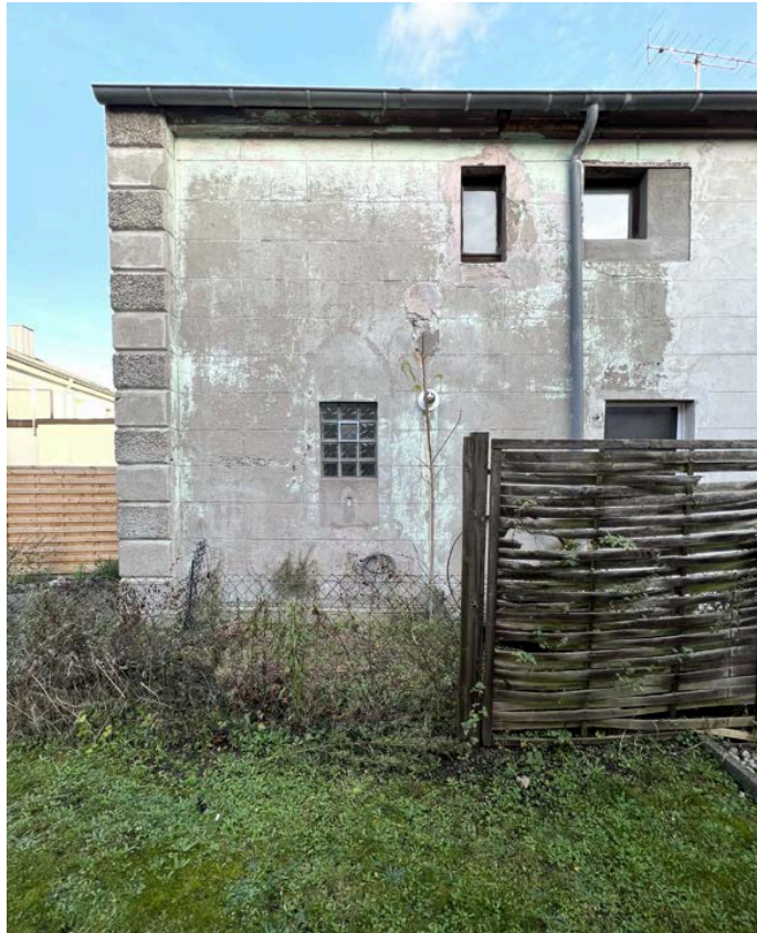
Stark überformte Südwestansicht
