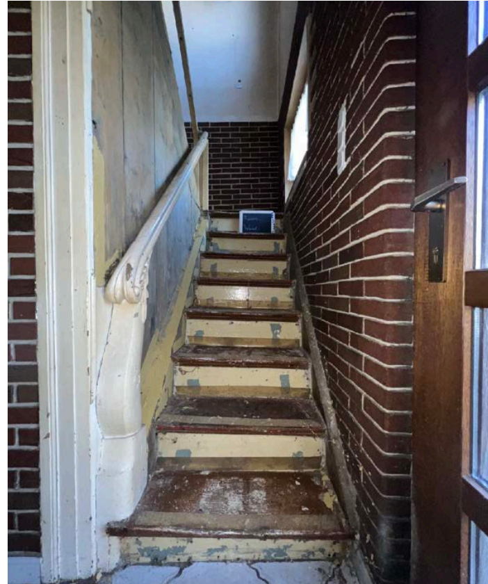
Aufgang der Treppe
