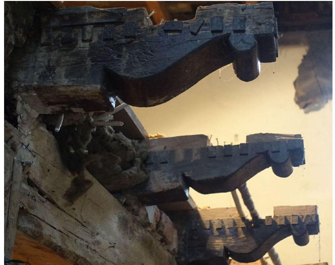
Freigelegte, verzierte Kopfbalken
