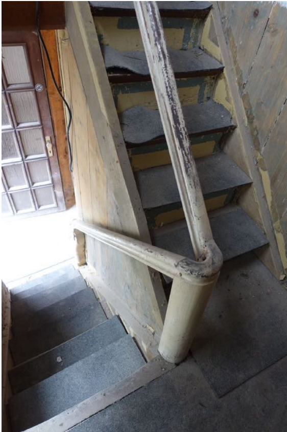
Treppenpodest mit Blick auf Eingangstür
