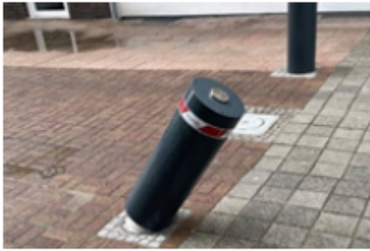
Abbildung 1: Beschädigter Poller (Quelle: eigene Darstellung)
