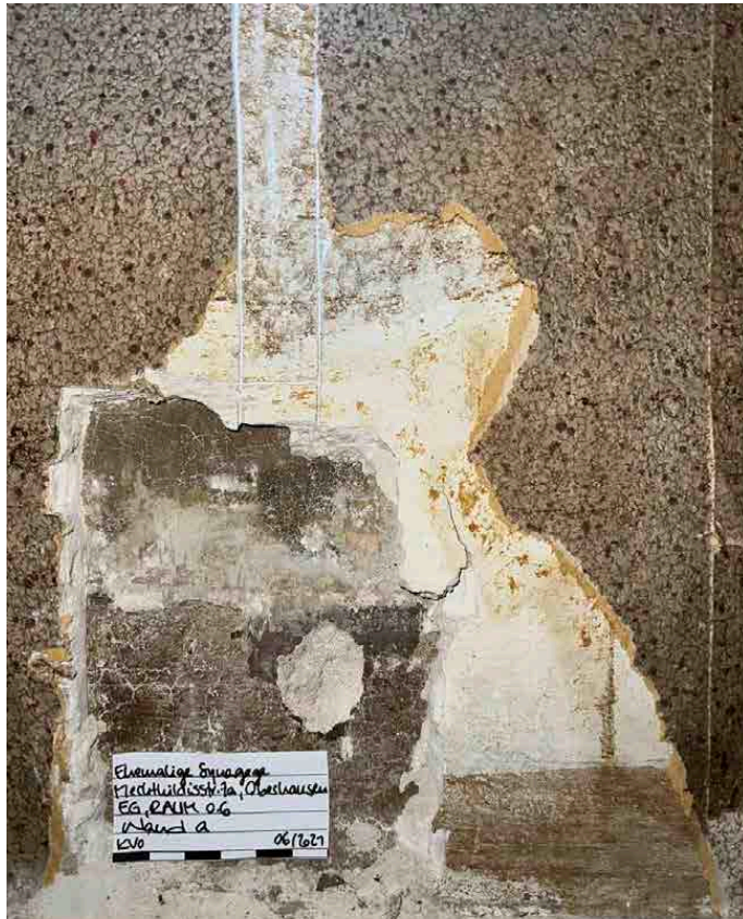
Befund einer Fassung an Rückwand Hauptraum
