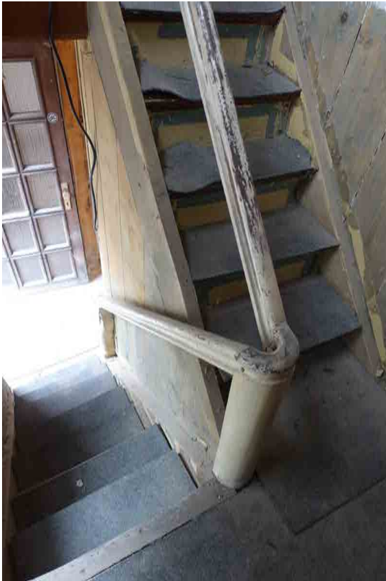
Treppenpodest mit Blick auf Eingangstür
