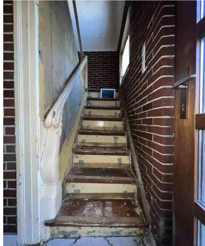
Aufgang der Treppe
