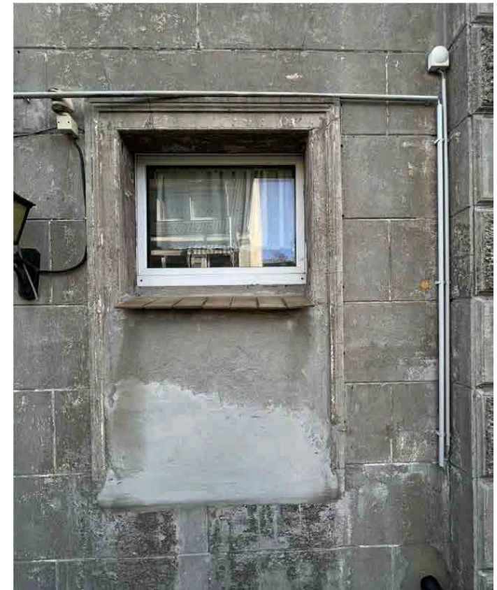
Neues Fenster in historischer Laibung.
